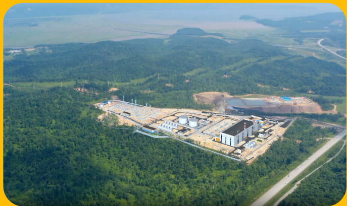
Строительство Артемовской ТЭС-2
