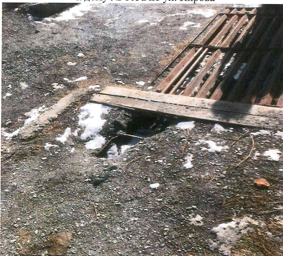
Фотография 4 – Фрагмент дворовой территории прилегающей к дому № 103а по ул. Кирова
