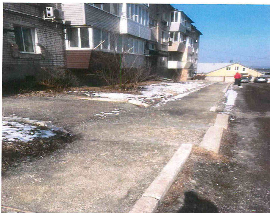
Фотография 2 – Фрагмент дворовой территории прилегающей к дому № 103а по ул. Кирова
