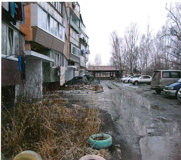
Фотография 1 – Фрагмент дворового проезда дома №8 по ул. Михайловская
