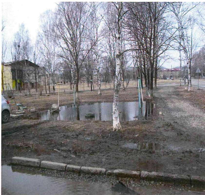
Фотография 2 – Фрагмент размещения бельевой площадки и тротуара на территории дома №8 по ул. Михайловская
